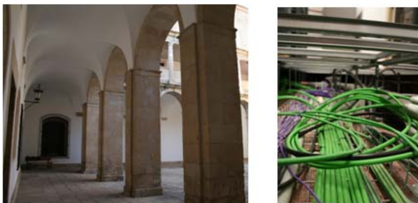
Detalle de las arcadas del patio del Claustro y de la red de cableado que recorre las instalaciones de CETA-Cjemat
