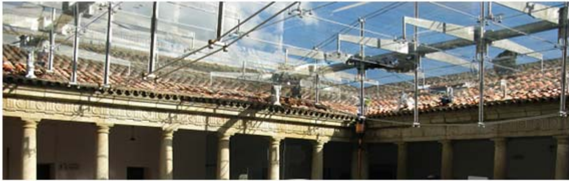
Detalle del cerramiento cenital del Claustro de San Francisco, sede del CETA-Ciemat
