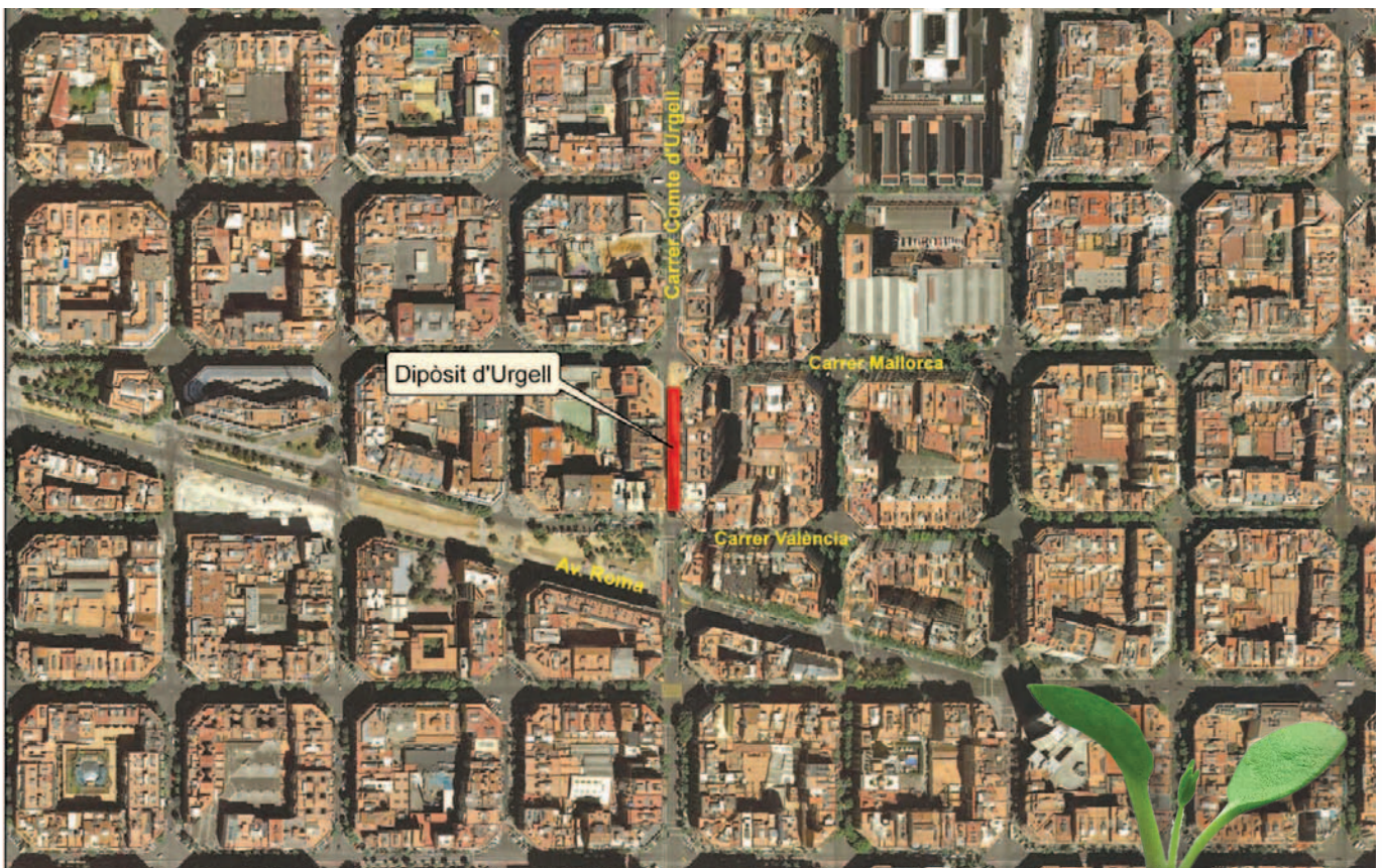
Depósito pluvial de la calle Urgell
