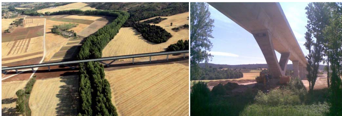
Mínima afección sobre el río durante la construcción
