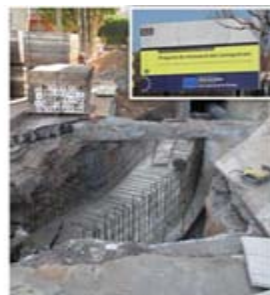
Proyecto de renovación del alcantarillado de la zona de Famades
