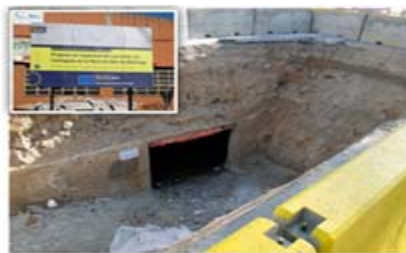
Proyecto de reparación del colector de la Avenida de la Mare de Déu de Bellvitge
