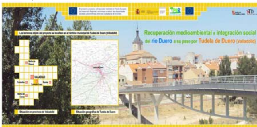
Portada y contraportada del folleto de la obra: Recuperación Medioambiental e Integración Social del río Duero a su paso por Tudela de Duero (Valladolid)
