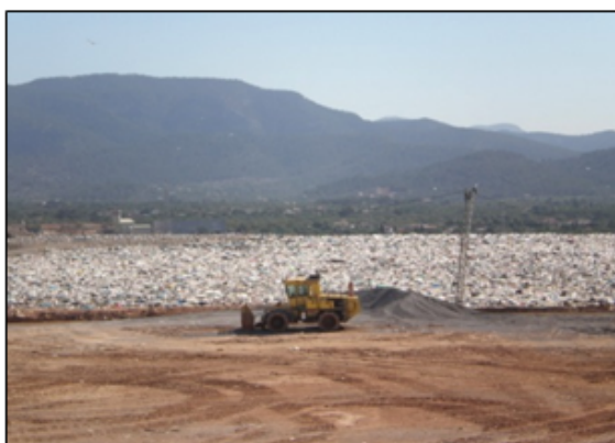
Estado del vertedero antes de iniciarse las obras
