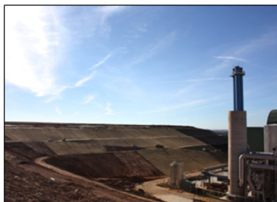
Vista durante la fase de impermeabilización.
