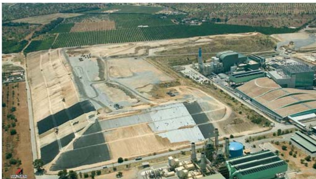
Vista aérea del sellado e impermeabilización del vertedero de “Son Reus”
