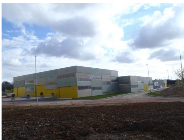
Pretratamiento en interior de edificio totalmente desodorizado
