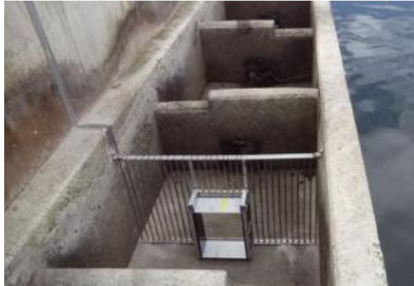
Contador de peces instalado en el azud de Sahechores
