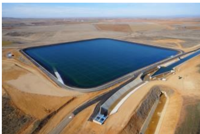
Canal, aliviadero, balsa y obra de toma de sifón.
