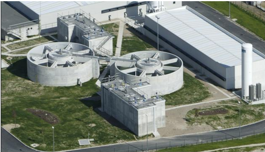
Cámaras de ozonización, previas y posteriores a la decantación. A la derecha: Tanque de O 2
