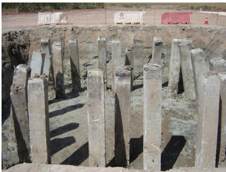
Con los equipos existentes en el mercado era difícil garantizar la estabilidad de la perforación de los pilotes en las zonas asociadas a gravas y arenas con presencia de agua, ya que ésta, puede llegar a lavar los lodos mezclándose las arenas o gravas con el hormigón no garantizándose entonces la integridad en toda la longitud del pilote.
