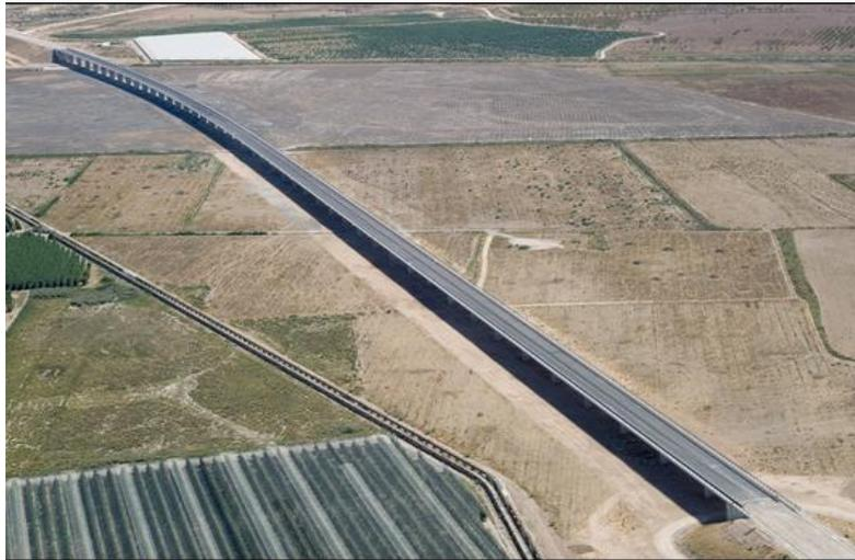
El diseño del Viaducto del Cordel del Camino del Sax, situado sobre la vía pecuaria que le da nombre, está fuertemente condicionado por razones geotécnicas. Salva un tramo que discurre sobre sedimentos cuaternarios de tipo palustre constituidos por arcillas limosas, las cuales presentan muy baja resistencia y alta deformabilidad.
