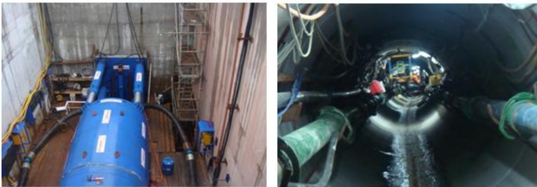
Sistema de guiado LASER Láser teodolito instalado en hincas en curva
