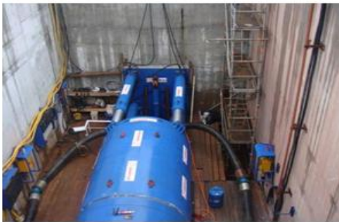
Placa de apoyo atornillada a muro de reacción Dibujo estación principal de empuje AVN2000D
