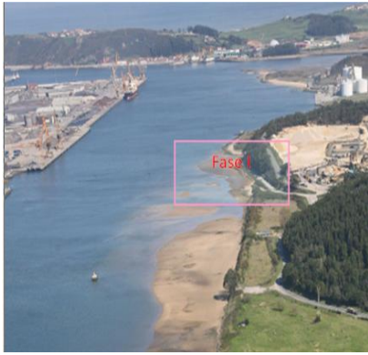
Situación anterior a la obra
