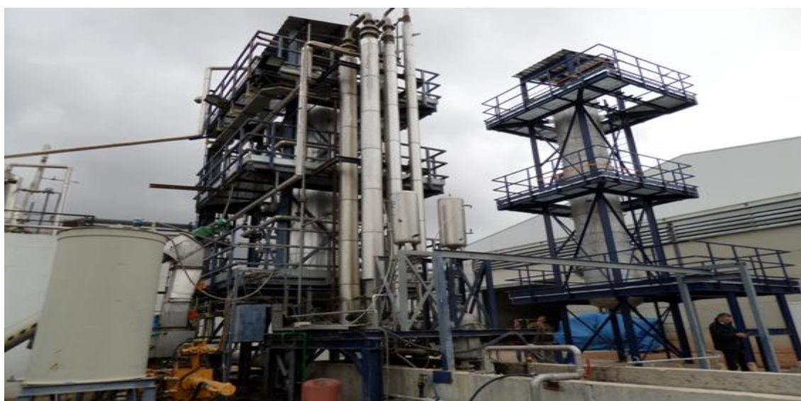
Instalación del segundo reactor
