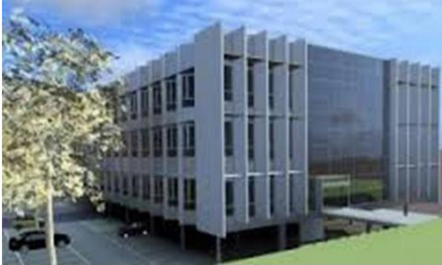
Edificio Lucia de la Universidad de Valladolid
