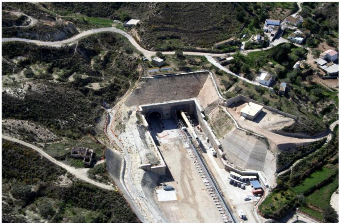
El túnel de Sorbas de tipología bitubo, tiene una longitud total de 7.528 m en el tubo I, y 7.520 m en el tubo II, incluyendo los cuatro falsos túneles de entrada y salida de 96 m de longitud cada uno, y está compuesto de dos tubos en paralelo dotados cada uno de ellos de vía única electrificada y dos andenes.
