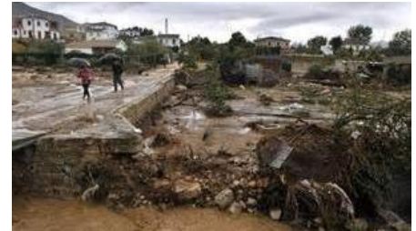
Efecto de la inundación en Villanueva del Rosario, Málaga. España (2013).
