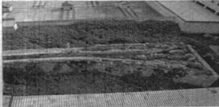
En una segunda fase se está realizando los los restos de la Acopla Real, obra que se está realizando en Camp Redó.
