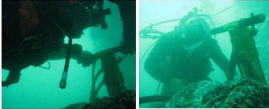
Trabajos de dragado en roca con martillo y cilindro hidráulico
