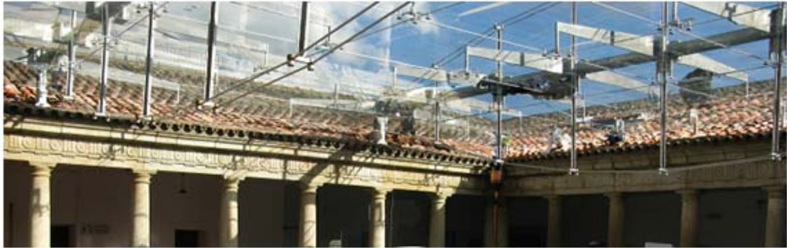
Detalle del cerramiento cenital del Claustro de San Francisco, sede del CETA-Ciemat
