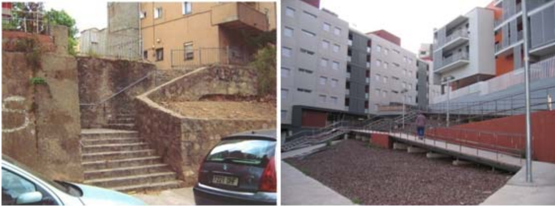
Acceso des de la calle Palamós: Estado inicial y final
