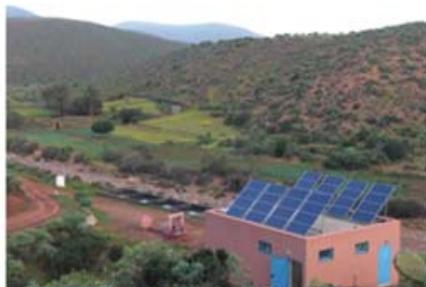
Vista general de sistema de desalación autónomo con energía solar fotovoltaica instalado en un douar de la Comunidad Rural de Amellou (provincia de Tiznit) (Enero 2009) - Marruecos
