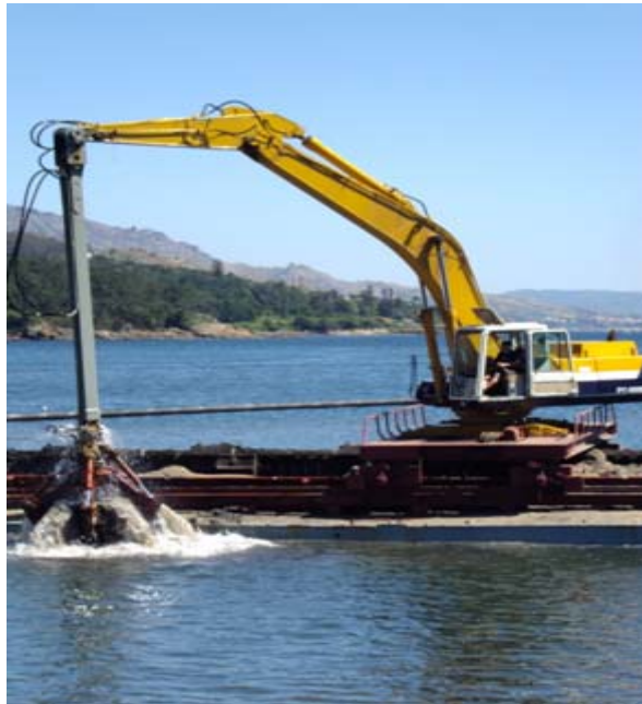
Detalle de los trabajos de dragado
