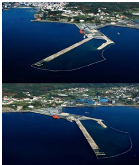
Ampliación del Puerto de Brens , en Cee (A Coruña)
