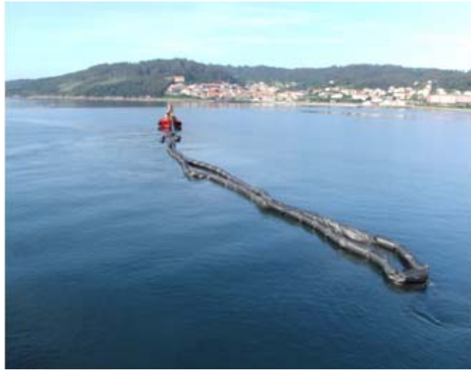
Colocación de barrera antiturbidez
