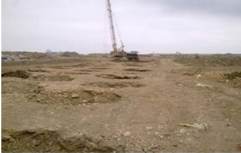
Compactación dinámica en viales
