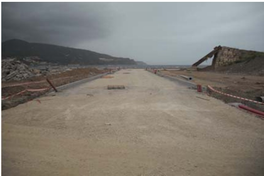
Ejecución de infraestructuras en viales
