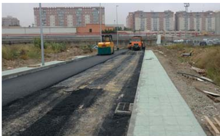
Extendido de aglomerado en viales
