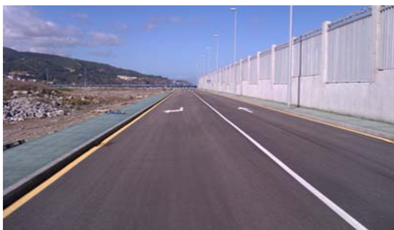
Vista general zona industrial (viales)
