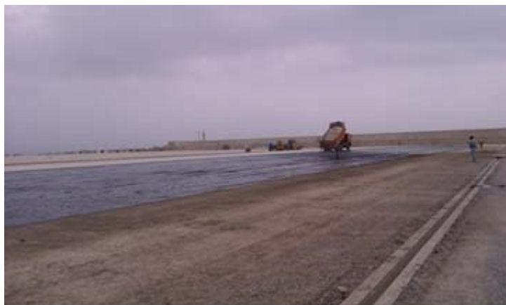
Ejecución de doble tratamiento superficial en zona ZAL
