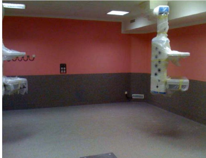
Quirófano en fase de construcción
